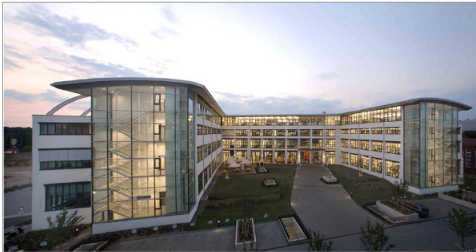
Büroimmobilie „LOFT 12“ in Düsseldorf
